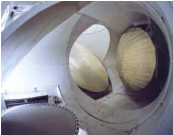
⑦ ビーム伝送部 7枚の反射鏡、周波数選択板および外筒により構成され、副反射鏡とホーンの間で電波を効率良く伝送します。
