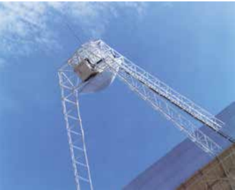
② 副反射鏡 主反射鏡とビーム伝送部の間で電波の受け渡しを中継する凸面鏡です。
