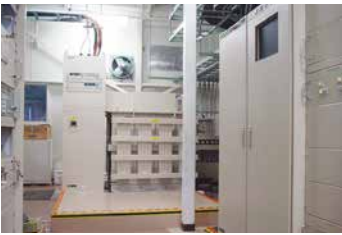
⑩ X帯送信設備 20kw出力の水冷式クライストロンです。
