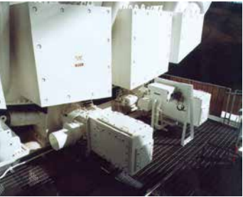
③ 仰角(EI)回転機構部 アンテナの仰角を制御する機構です。
