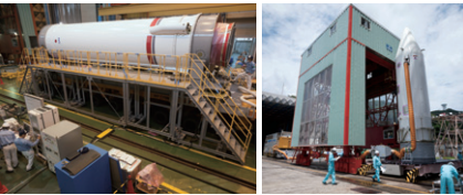
左:Mロケット組立室内の様子 右:門型クレーンにより整備塔へ移動 (画像:JAXA/JOE NISHIZAWA)
