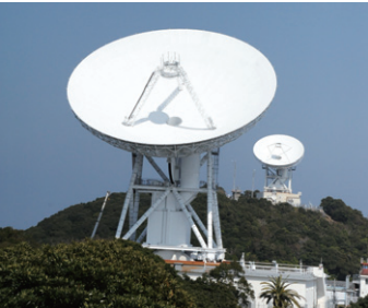
34mアンテナ(左)・20mアンテナ(右)
